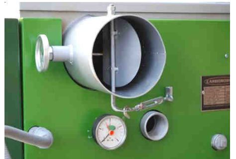
1.12 Füstelvezető kézi huzatszabályzóval
